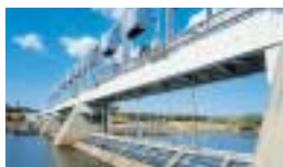
【標津川観覧橋】
